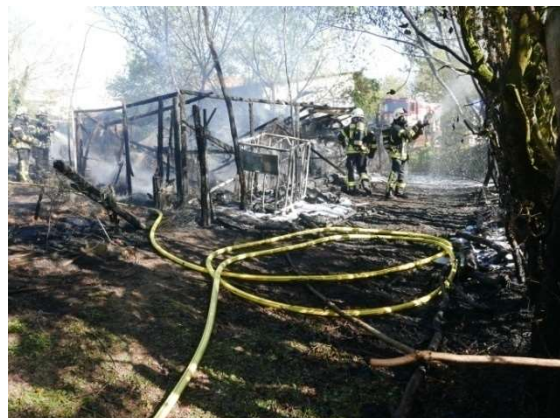
ausgebranntes landwirtschaftliches Gebäude
