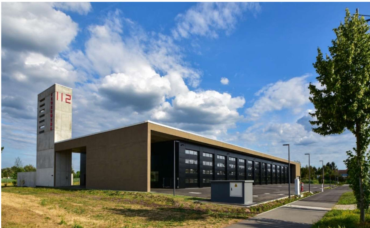
Das neue Feuerwehrgerätehaus der FF Arheilgen dient auch als Ausbildungsstandort für die Freiwilligen Feuerwehren und der Berufsfeuerwehr.
