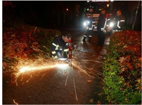
Abflexen eines Sperrfostens
