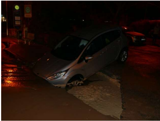
eingebrochener PKW in unterspülte Straße
