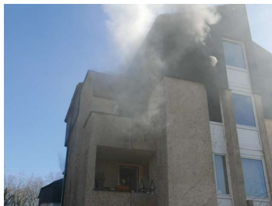
Feuer im 2. OG eines Mehrfamilienhauses
