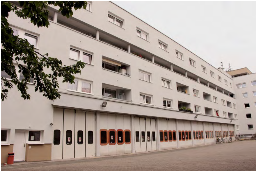
Das Gerätehaus der Freiwilligen Feuerwehr Innenstadt im Hinterhof der Kasinostraße
