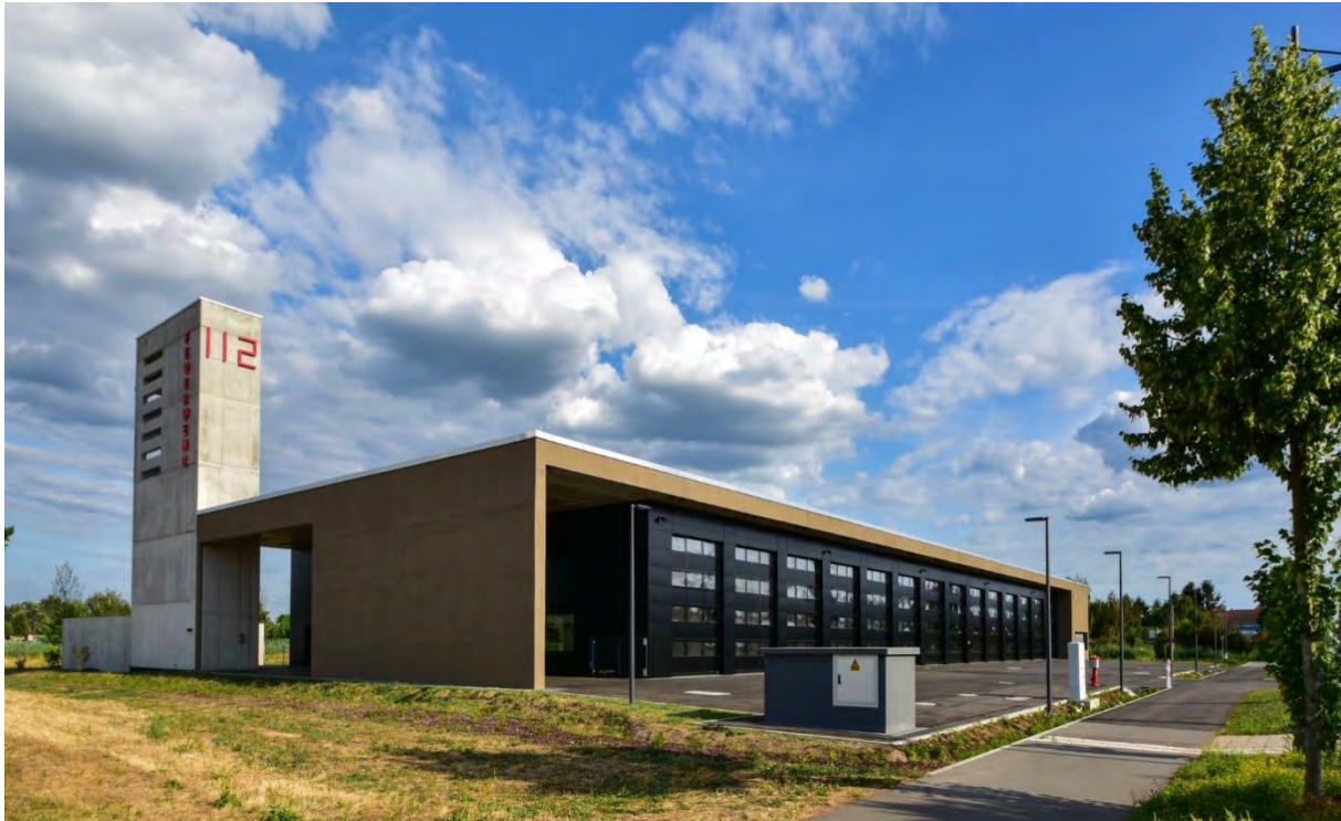
Das neue Feuerwehrgerätehaus der FF Arheilgen dient auch als Ausbildungsstandort für die Freiwilligen Feuerwehren und der Berufsfeuerwehr.
